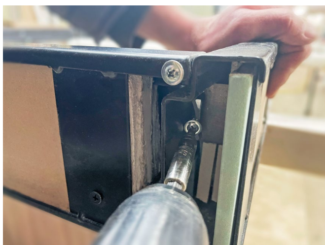
4. Skrue skrues nu i punkt C og D (fig.3) i den inderste del af karmen punkt 3/4 (fig.1).
